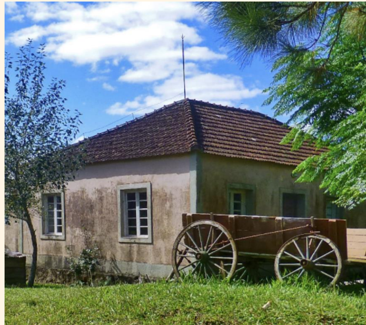
Casa na zona rural onde funcionou uma fábrica de doces artesanal. Atualmente ocupada por uma família como habitação. Fotografia: Autora, 2024.
